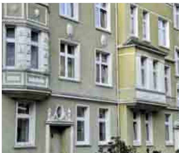
Wohnen wie zu Kaisers Zeiten: Der denkmalgeschützte Althoffblock in der Dortmunder Innenstadt ist Heimat für rund 2 000 Bewohner, etwa jeder Fünfte hält Kontakt zum Nachbarschaftstreff des Caritasverbandes und des Spar- und Bauvereins.
